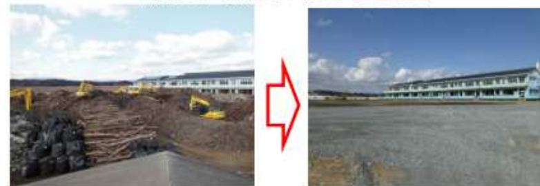
撤去前(平成26年1月) 撤去後(平成27年3月) 浪江町における津波がれきの撤去状況
